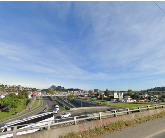
PASO SOBRE NIVEL DE CAMINO A PENCO
